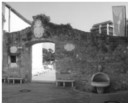
Resti della cinta muraria "in Ponte"
